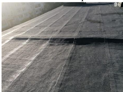
Наша новая кровля.
