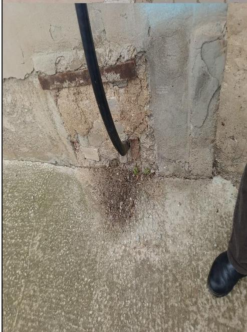
ПЛИТ) ВИДНЫ ВЛАЖНЫЕ СЛЕДЫ, А ТАКЖЕ УСТАНОВЛЕНА ЧАСТЬ КОНСТРУКЦИЙ ОТЛИВ НА КРОВЕЛЬНОМ ПОКРЫТИИ, ЧТО ЯВЛЯЕТСЯ НЕБЕЗОПАСНЫМ УСТРОЙСТВОМ ДЛЯ ОТЛИВА, В РЕЗУЛЬТАТЕ ЧЕГО МОЖЕТ ПРИВЕСТИ К РАЗРУШЕНИЮ КИРПИЧА НА ФАСАДЕ, ПОПАДАНИЕ ПОД ФУНДАМЕНТ, ПРИ ЭТОМ ПРЯМАЯ УГРОЗА ПРИЧИНЕНИЯ ВРЕДА ЖИЗНИ И ЗДОРОВЬЯ ЛЮБЫМ УЧАСТНИКАМ ПРОХОДЯЩИМ ВДОЛЬ СТЕНЫ МКД.
